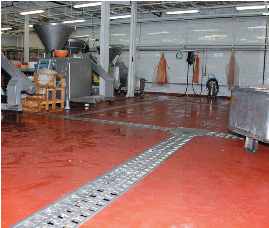
Благодаря большой толщине и применяемым высокопрочным заполнителям такие полы с легкостью выдерживают самые тяжелые механические, абразивные и ударные нагрузки
